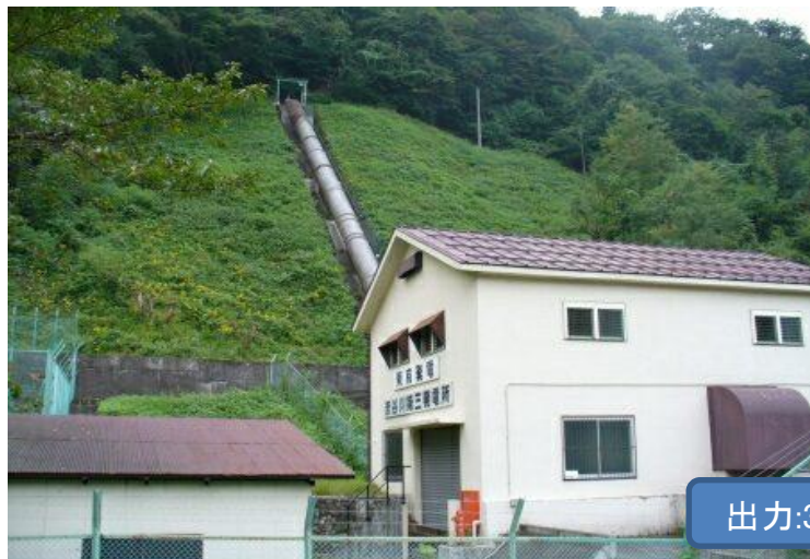
赤谷第二発電所：群馬県
