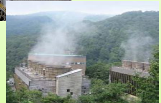
【地熱発電設備】
