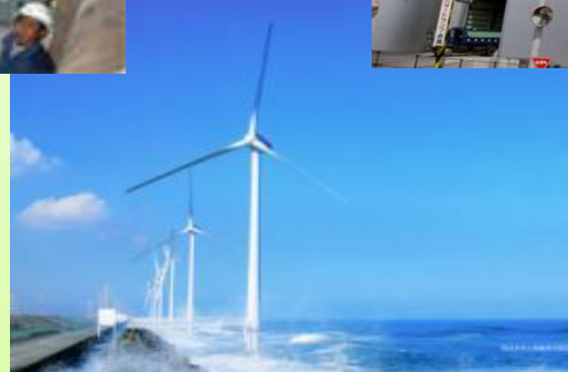
【風力発電設備】
