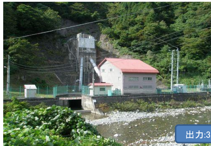
新小滝川発電所：新潟県
