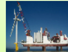
専用船や大型台船1隻で施工（現状、日本は2隻で施工）
