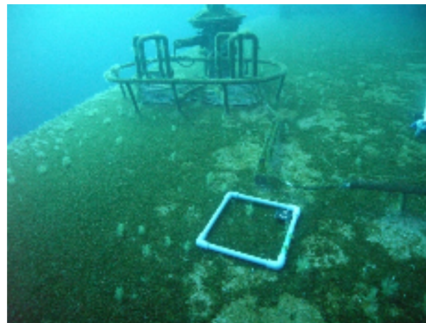
ミドルハルトップデッキ面には 珪藻類が付着 (水深14.7m)
