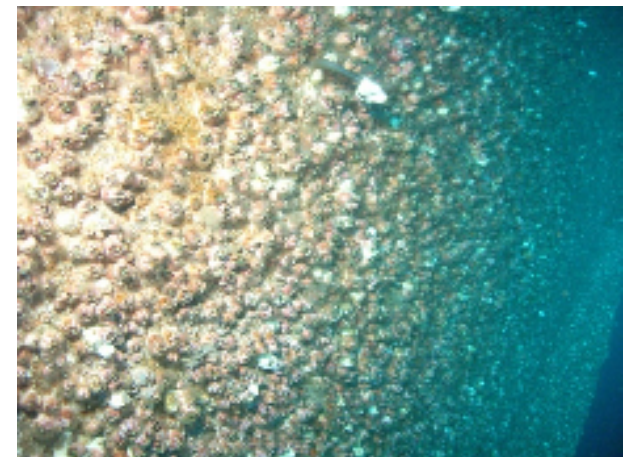
ミドルハルの側面にはフジツ ボ類が付着 (水深15.3m)
