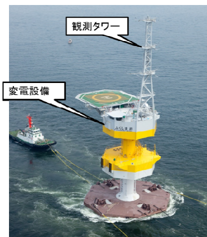
浮体式洋上風力変電設備
