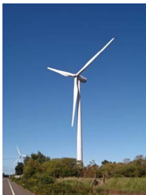
いしかり市民風力発電所 2008年1月営業運転開始
