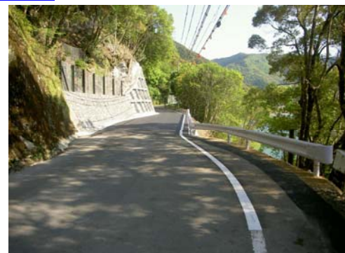
整備後 国道441号 岩間~久保川(四万十市)
