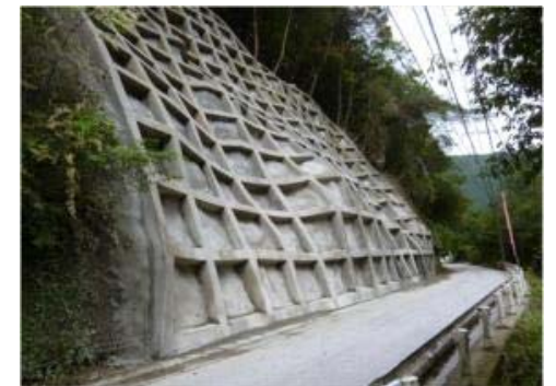
整備後 県道安田東洋線 与床~久江ノ上(安芸郡北川村)
