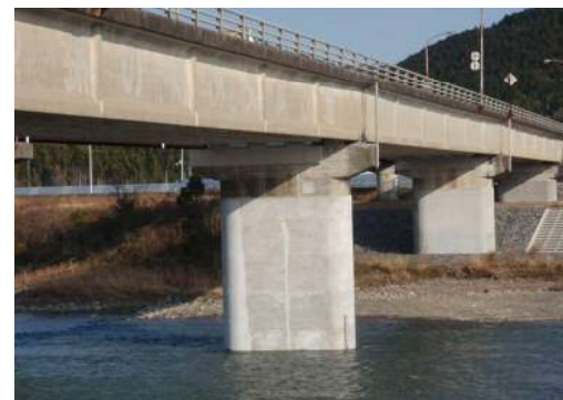
整備後 県道土佐山田野市線 戸板島橋(香美市)
