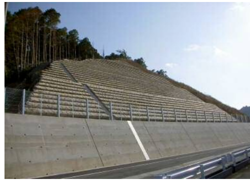
整備後 国道321号 加久見～下川口工区(土佐清水市)
