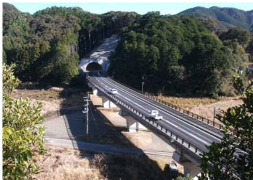
整備後 国道441号 川登バイパス(四万十市)
