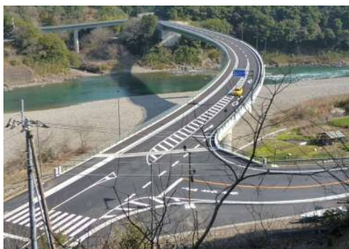
整備後 国道441号 網代バイパス(四万十市)
