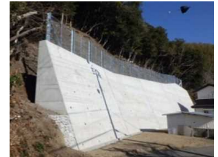
など <土砂災害対策（急傾斜地崩壊対策事業）>
