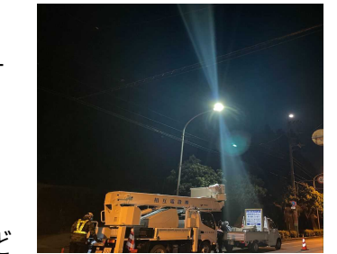
道路照明LED化
