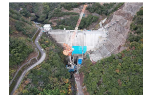
<建設中の和食ダム>
