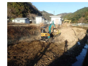
<河川に堆積した土砂の浚渫>
