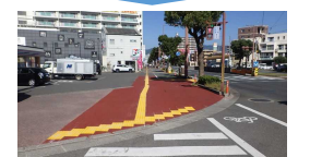
地域の安全安心推進事業 (舗装修繕)
