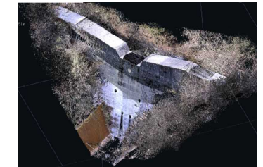
砂防堰堤の3次元点群モデル
