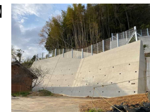
など <土砂災害対策（急傾斜地崩壊対策事業）>
