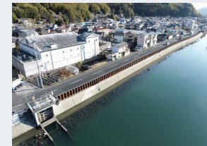
河川堤防の耐震化 (下田川)
