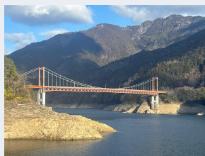
橋梁の長寿命化修繕 (県道本川大杉線 上吉野川橋)
