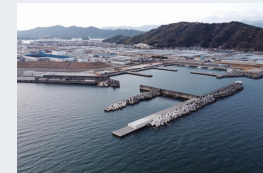
港湾の防波堤整備 (高知港)
