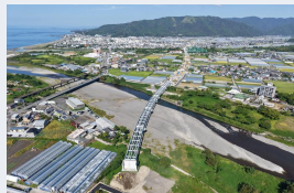
四国8の字ネットワーク 阿南安芸自動車道 安芸道路
