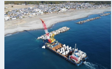
離岸堤の整備 (野根海岸)
