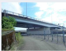
橋梁耐震対策 (国道195号 曙大橋)
