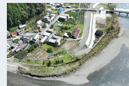
河川の堤防整備 (安芸川)
