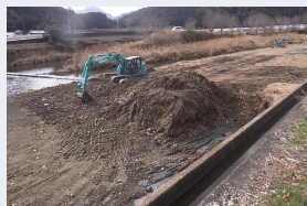
河川浚渫 (柳瀬川)
