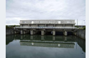
施設点検予定箇所 (後川防潮水門)
