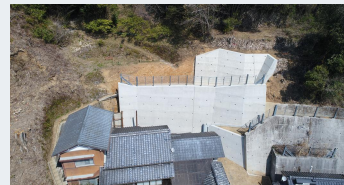
急傾斜地崩壊対策事業 (大八十地区)
