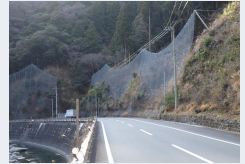
法面防災対策 (県道安田東洋線)
