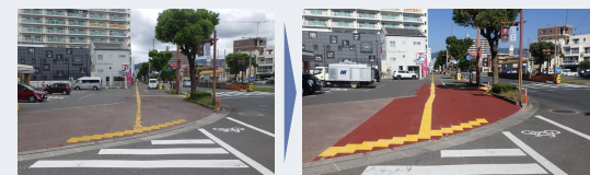
地域の安全安心推進事業(舗装修繕)
