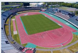
都市公園施設の整備 春野総合運動公園 陸上競技場
