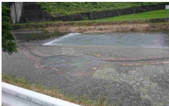
蜷川河川プール
