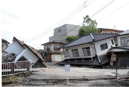
住宅损毁（益城町）（提供 熊本县益城町）
