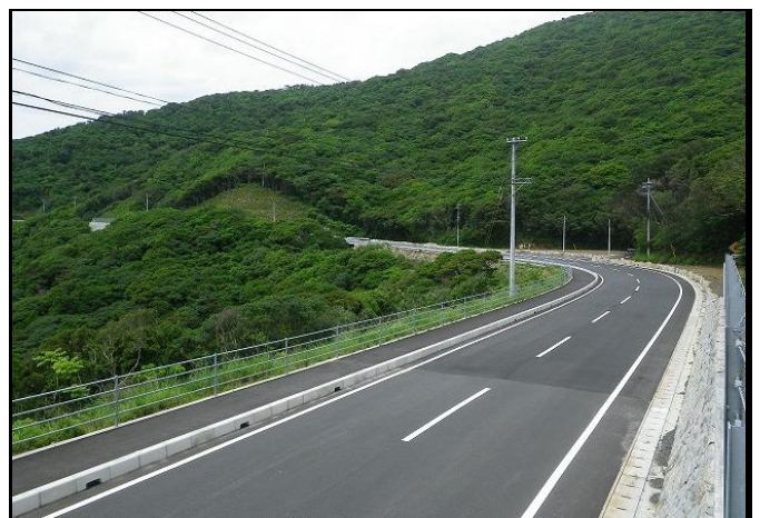
道交地(交安)第34-005-14号 月灘建設株式会社
