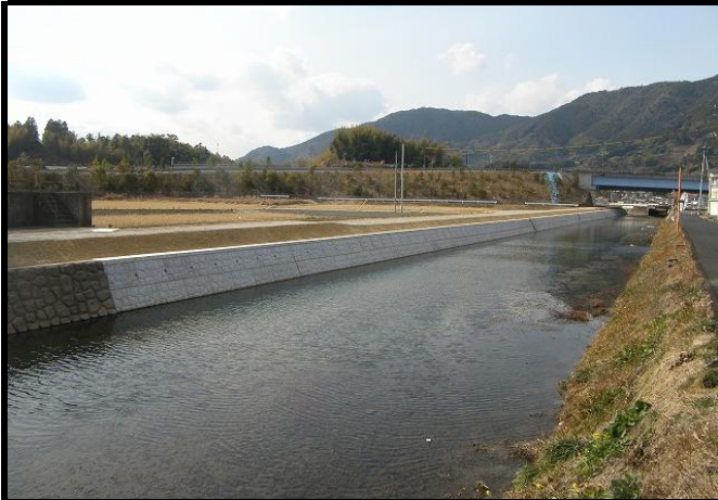
広域基幹第1-3号 新進建設株式会社
