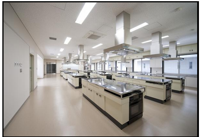
機第20-14号 寿・昭栄設備特定建設工事共同企業体
