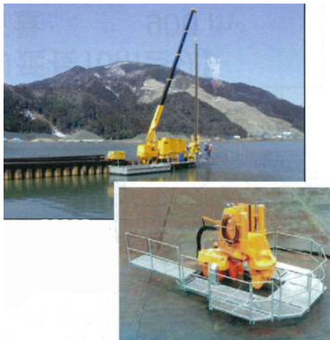
鋼矢板の圧入工法
