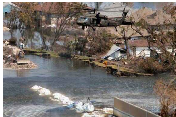
中央防災会議「大規模水害対策に関する専門調査会」資料 ヘリコプターによる土のう空輸
