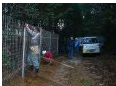
鳥獣害防護柵設置
