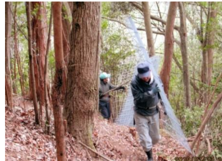
金網防護柵の設置
