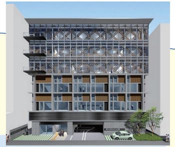
高知県自治会館新庁舎 ○3FまでRC(鉄筋コンクリート)造 ○4~6Fは木造軸組+CLT
