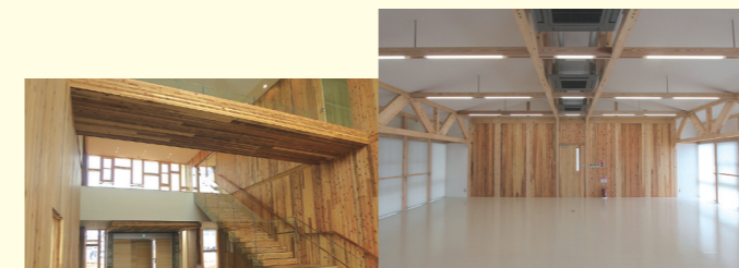
木造軸組とCLTによる 広い室内空間
