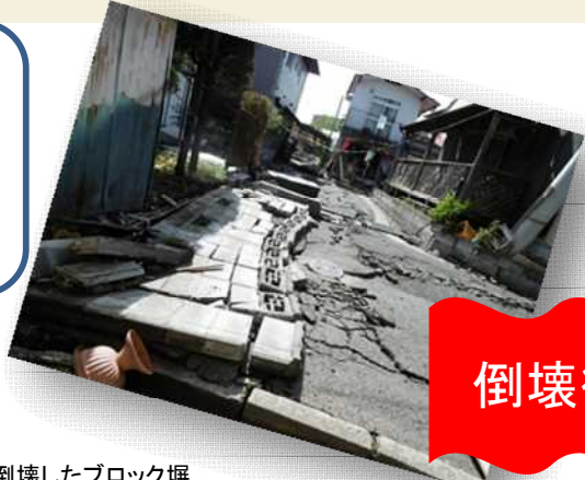
熊本地震で倒壊したブロック塀
