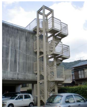
外階段を設置した事例
