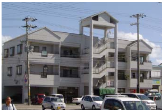
共同住宅に津波避難ビルの機能を付加した事例
