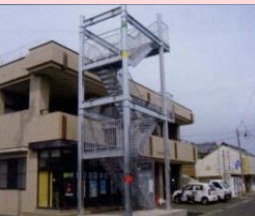
避難ビル(外階段)
