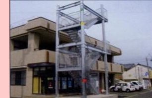
避難ビル(外階段)
