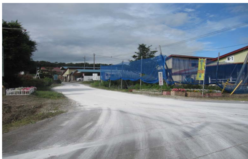
消石灰帯の設置
