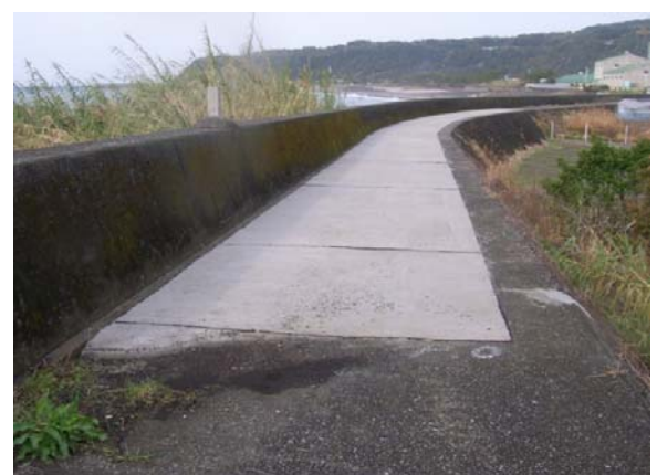
整備後（天端被覆工）
