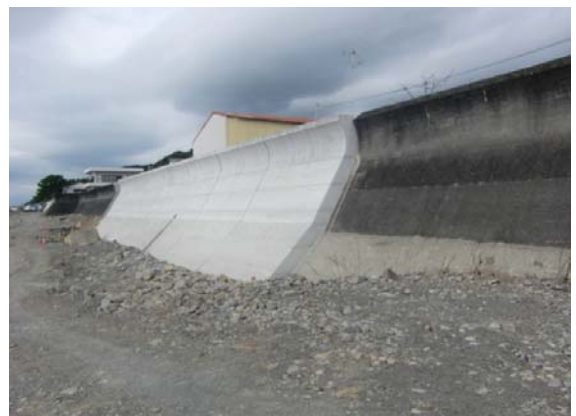
整備後（表のり被覆工）
