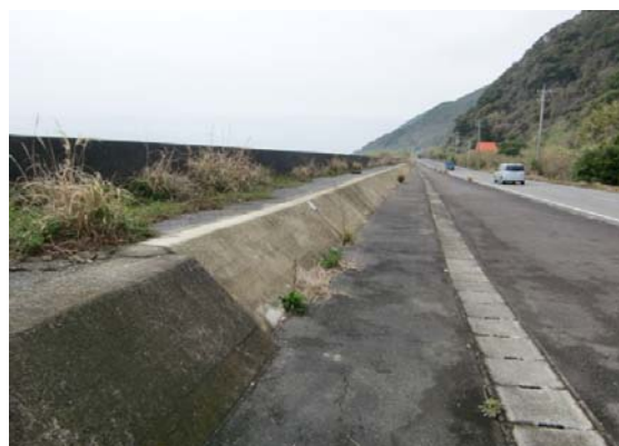
整備後（裏のり被覆工）
