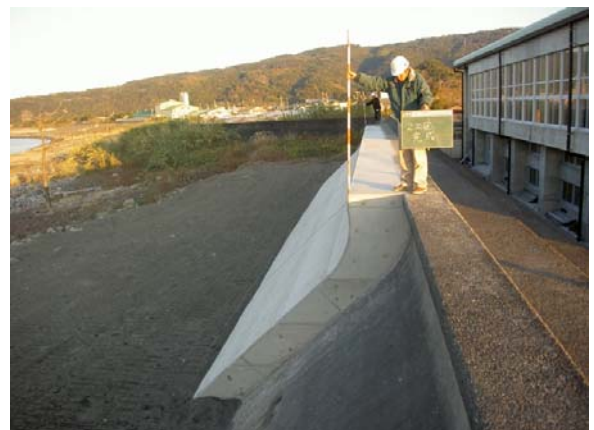
整備後（表のり被覆工）
