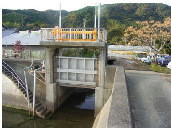
整備後（二工区）
