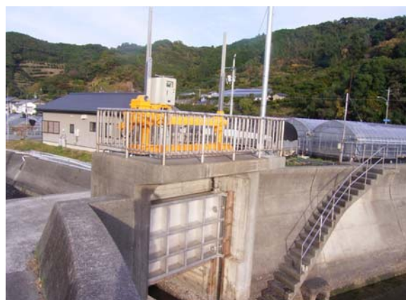
整備後（一工区）
