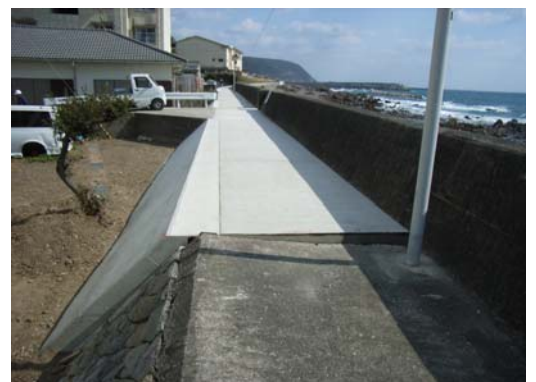
整備後（裏のり被覆工・天端被覆工）
