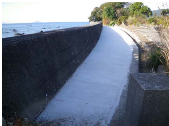
整備後（天端被覆工）
