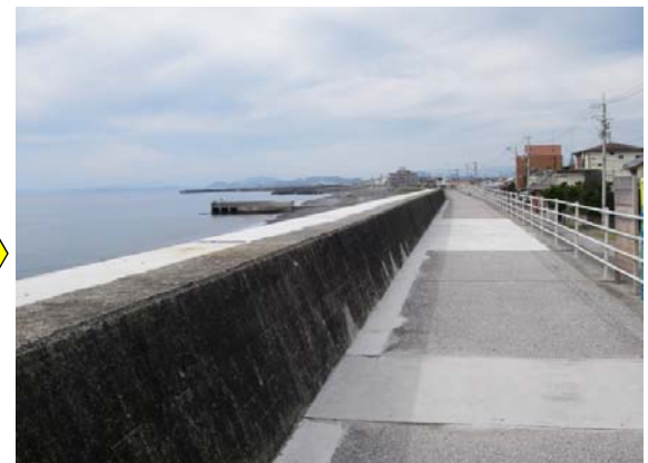
整備後（天端被覆工）
