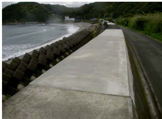
整備後（天端被覆工）
