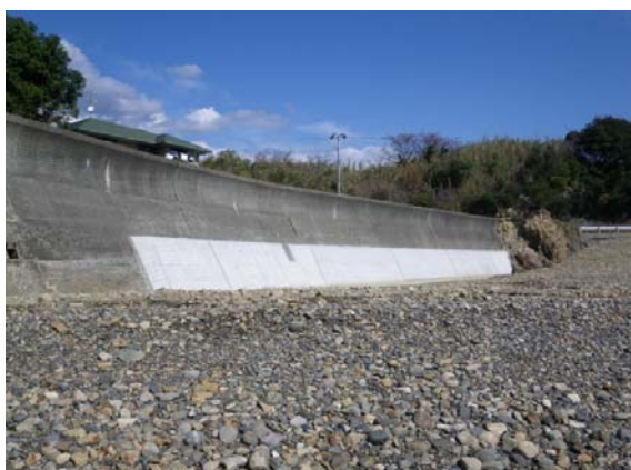
整備後（表のり被覆工）
