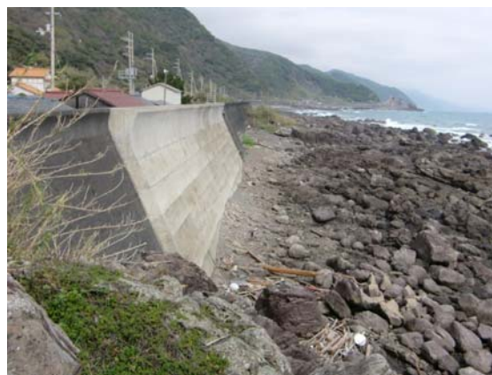
整備後（表のり被覆工）
