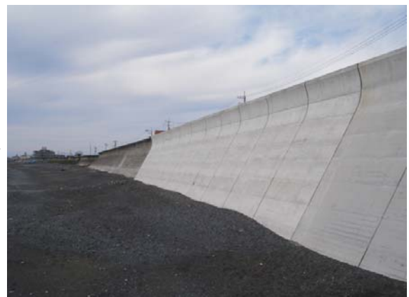
整備後（表のり被覆工）
