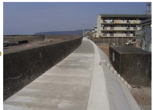
整備後（裏のり被覆工・天端被覆工）
