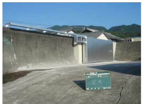
整備後（陸閘設置）
