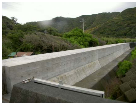
整備後（表のり被覆工）
