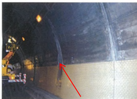
図 1.6 覆工スパンの中間付近に発生する変状の例 (P. 巻末資料 1-17 文献 1) 参照)
