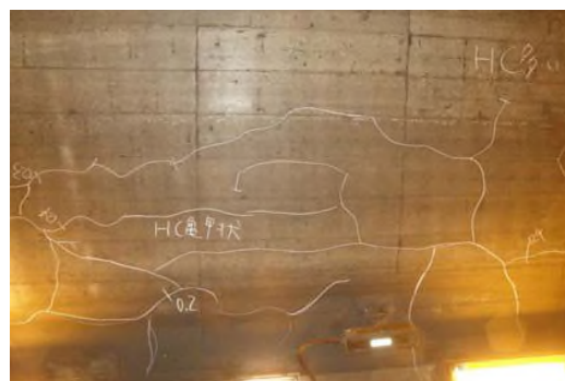
写真 1.6 複数のひび割れで覆エコンクリートがブロック化している例 (P. 巻末資料 1-17 文献 1) 参照)
