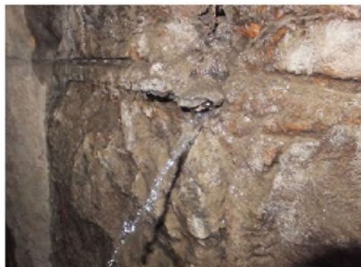
写真 1.8 漏水（噴出）している例（P. 巻末資料 1-17 文献 1) 参照）
