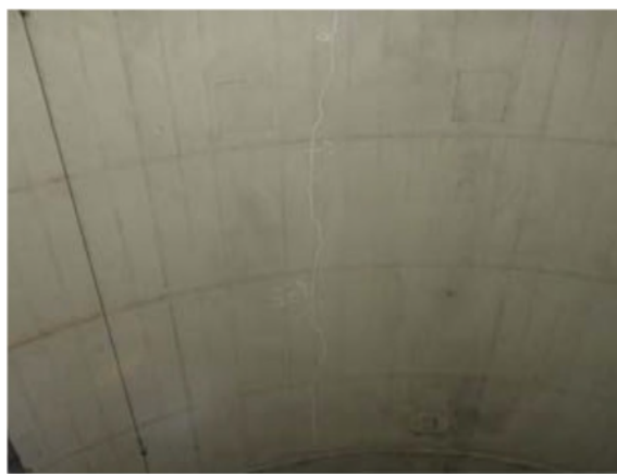
写真 1.4 覆工の天端付近に発生した縦断方向のひび割れの例 (P. 巻末資料 1-17 文献 1) 参照)
