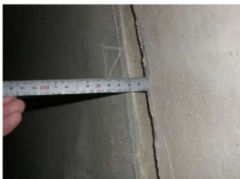
図 1.11 目地部、打継ぎ目部の段差の例
