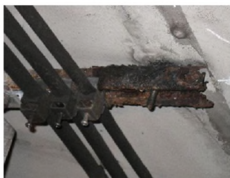
写真 1.13 固定金具の腐食とアンカーボルトの脱落の例（P. 巻末資料 1-17 文献 1) 参照）
