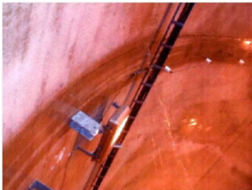
写真 1.8 漏水（噴出）している例（P. 巻末資料 1-17 文献 1) 参照）
