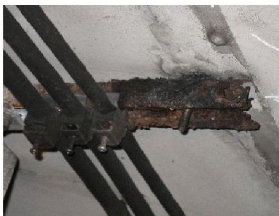
図 2.3 固定金具の腐食とアンカーボルトの脱落の例（巻末資料 P2-44 文献 1) 参照）
