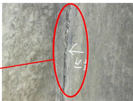
写真 1.9 段差の例（P. 巻末資料 1-17 文献 1) 参照）
