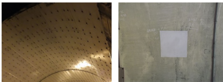
写真 1.11 鋼板接着；左・繊維シートの接着；右の例（P. 巻末資料 1-17 文献 1) 参照）
