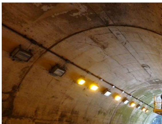
写真 1.4 覆工の天端付近に発生した縦断方向のひび割れの例 (P. 巻末資料 1-17 文献 1) 参照)
