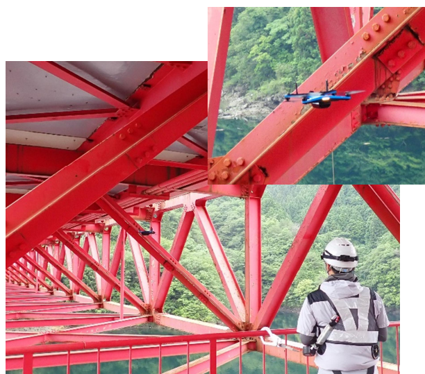
新技術による点検（ドローン）
