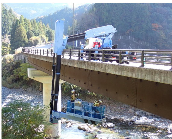
従来の点検手法（橋梁点検車点検）
