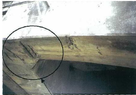
剥離・鉄筋露出が目視できる
