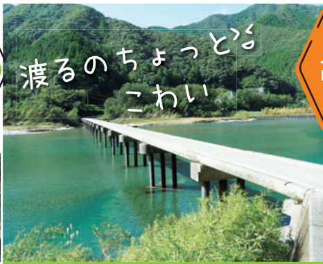
名古屋沈下橋
