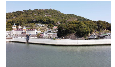
<三重防護（吸江工区）>
