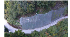
法面防災対策（国道195号）
