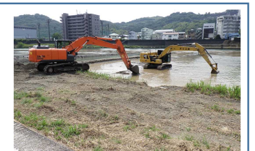
<河川に堆積した土砂の浚渫>
