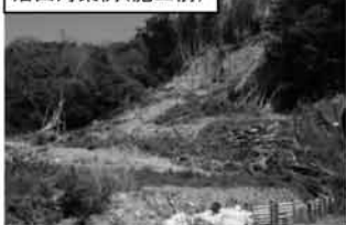
治山対策例(施工前)
