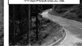
林道開設施工後
