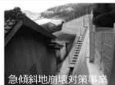
急傾斜地崩壊対策事業
