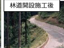
林道開設施工後
