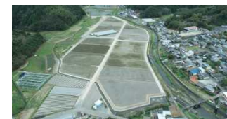
【志和地区(四万十町) ほ場整備】
