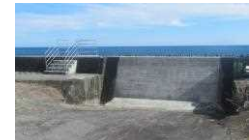
コンクリートによる陸こうの閉鎖
