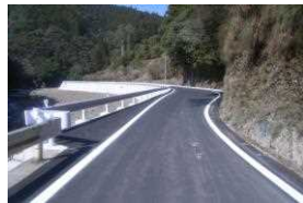
畑山栃ノ木線における1.5車線整備
