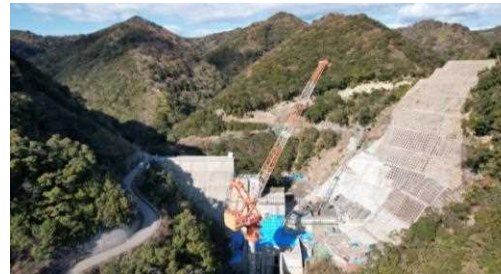
和食ダム建設
