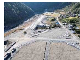
国道493号 (北川道路2-2工区)
