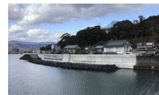
【高知港海岸】 (海岸堤防の耐震対策)
