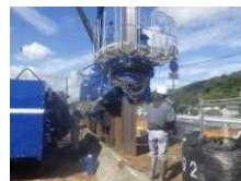
河川堤防の耐震対策
