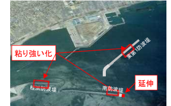
高知港防波堤の整備
