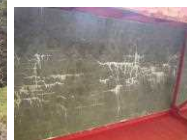
国道194号 石見橋の損傷状況
