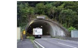
国道441号 網代トンネルの点検状況
