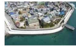
海岸堤防の耐震対策
