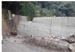
【瀬戸ヶ谷川】 (砂防堰堤の整備)
