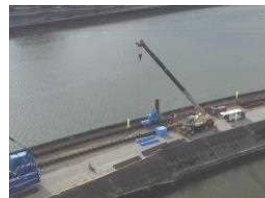
【国分川】 (河川堤防の耐震対策)
