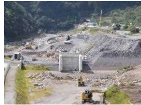
【国道493号】 (北川道路の整備)
