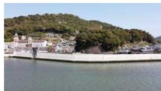
【高知港海岸】 (海岸堤防の地震・津波対策)
