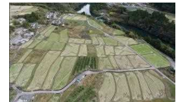
【永野地区 ほ場整備】
