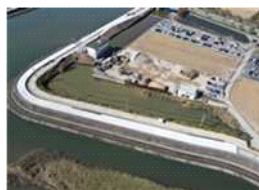
【国分川】 (河川堤防の耐震対策)
