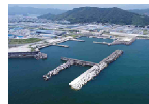
【高知港】 (港湾施設の地震・津波対策)
