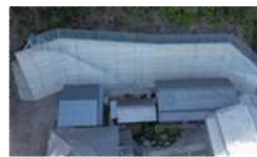
【仁西地区】 (急傾斜地崩壊防止施設の整備)
