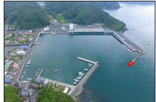
田ノ浦漁港 防波堤の粘り強い化整備
