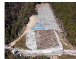
県道本川大杉線 (大川村下切~土佐町田井)
