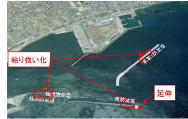
高知港防波堤の整備
