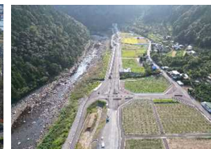
国道493号 (北川道路2-2工区)
