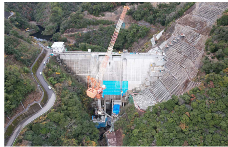
和食ダム建設
