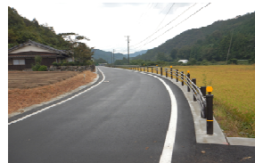
県道西土佐松野線における1.5車線整備
