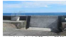
コンクリートによる陸こうの閉鎖
