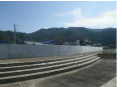
海岸堤防の耐震補強状況
