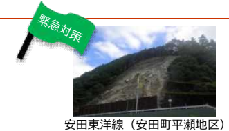
安田東洋線 (安田町平瀬地区)
