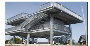
(津波避難タワー)
