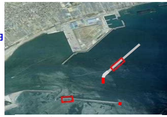
高知港防波堤の整備
