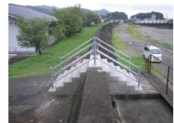
コンクリートによる陸こうの閉鎖
