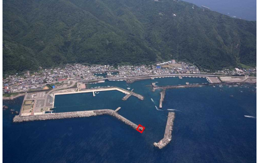
室戸岬漁港 沖防波堤の粘り強い化整備
