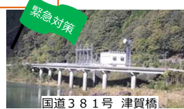
国道381号 津賀橋
