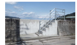
コンクリートによる陸こうの閉鎖
