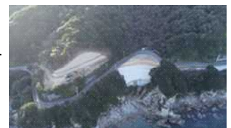
県道安満地福良線における線形改良
