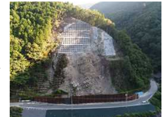
安田東洋線（安田町平瀬地区）
