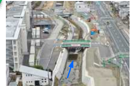
宇治川 (堤防整備)
