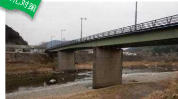
国道381号 窪川橋
