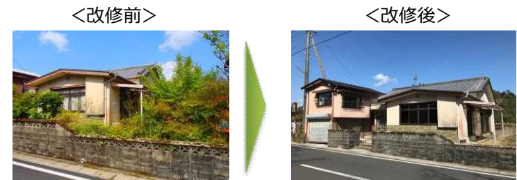
空き家の改修
