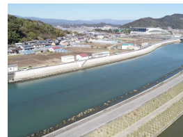
【下田川】 (河川堤防の耐震対策)
