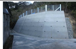
【久礼上沢地区】 (急傾斜地崩壊防止施設の整備)
