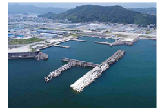
【高知港】 (港湾施設の地震・津波対策)
