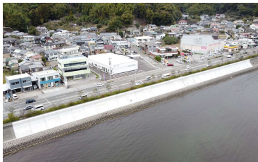
【高知港海岸】 (海岸堤防の耐震対策)
