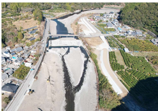
【安芸川】 (河川の堤防整備)
