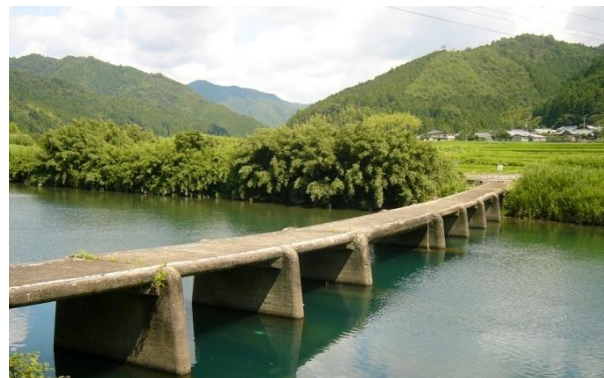
一斗俵沈下橋（四万十町）
