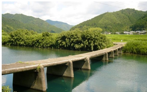
一斗俵沈下橋（四万十町）
