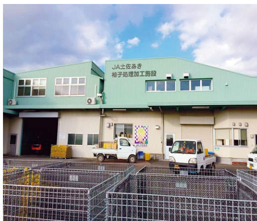
図4 ユズ搾汁工場外観 （JA土佐あき本所）
