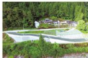
早明浦ダム貯水池進入路整備工事
