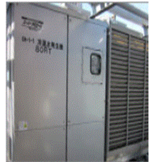
ガス冷温水発生器の更新
