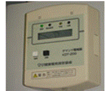
デマンド監視装置の導入
