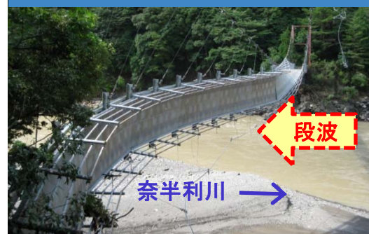
⑤ 平鍋吊橋 段波により破壊
