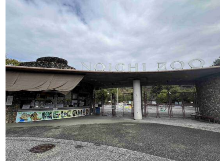
(入口ゲート窓口)
