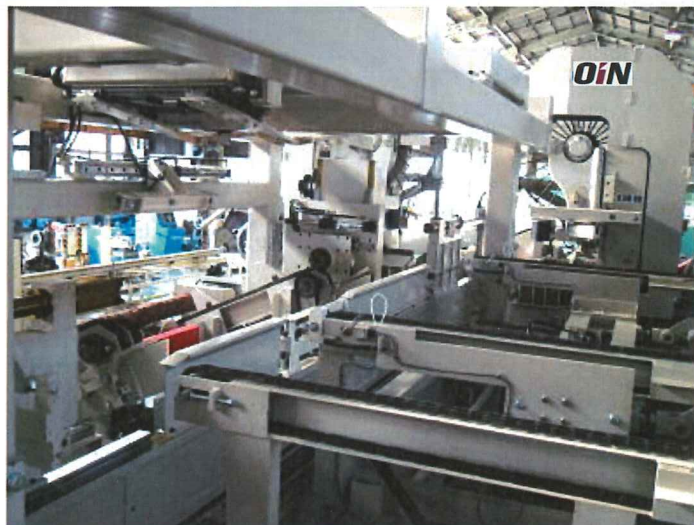
心材搬出側より帯鋸盤、プリセッターをみる。
