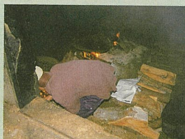
地下で薪を焚く。丸いタン板（飛行機）を吊して熱を分散させている。
