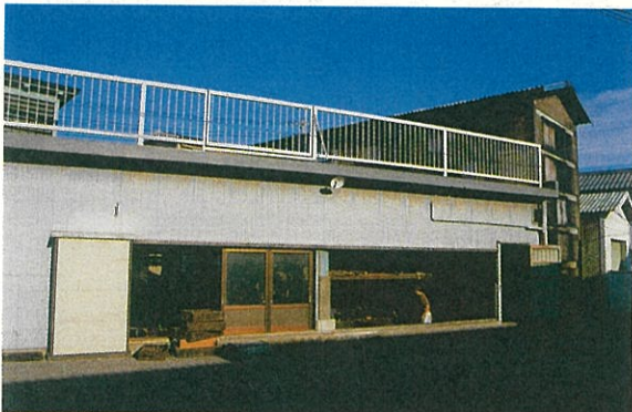
竹内商店製節工場 右側の五層の建物が焚き納屋。地下で火を焚いてカツオ節を燻す。左の建物は生切りやバラ抜きなどの作業場。昔は納屋といった。
