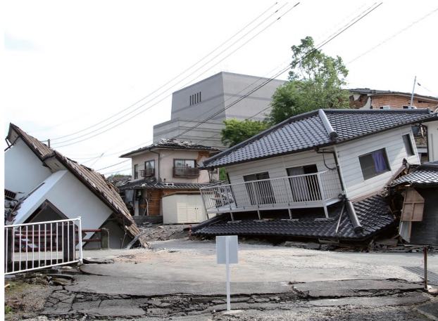
住宅被害（益城町）
