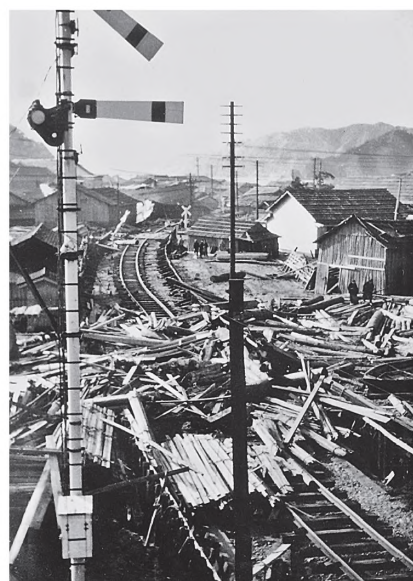
線路を津波による漂流物がふさぐ 須崎市浜町付近（提供 須崎市）
