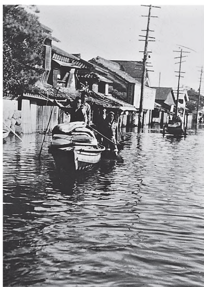
地盤沈下による浸水 高知市城見町付近
