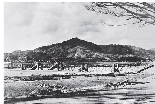
揺れによる橋の落下（9径間のうち6径間が落ちた。） 四万十市四万十川橋付近
