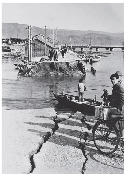
揺れによる堤防の決壊 高知市葛島付近
