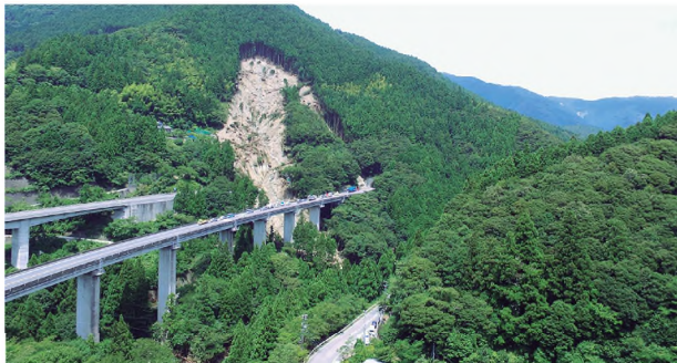
【平成30年7月豪雨 2018年6月29日～7月9日】 宿毛市をはじめとする6市町村に高知県初となる大雨特別警報が発表され、この豪雨により、死者3名、軽傷1名の人的被害が発生したほか、高知自動車道の立川橋の流出や、県内50地区が孤立するなど、甚大な被害が生じた。
