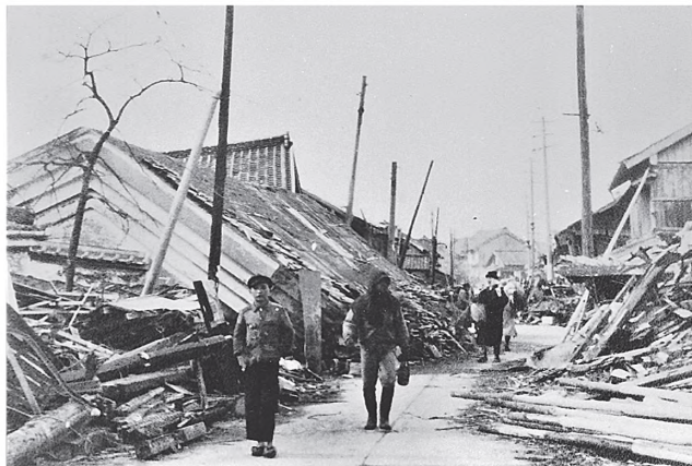
家屋の倒壊 四万十市中村大橋通二丁目付近
