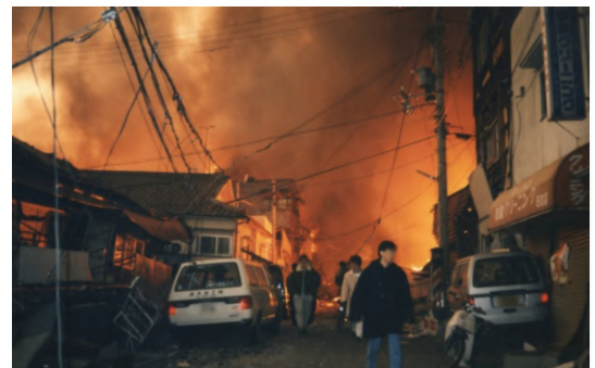
阪神・淡路大震災での火災の様子(提供 神戸市)
