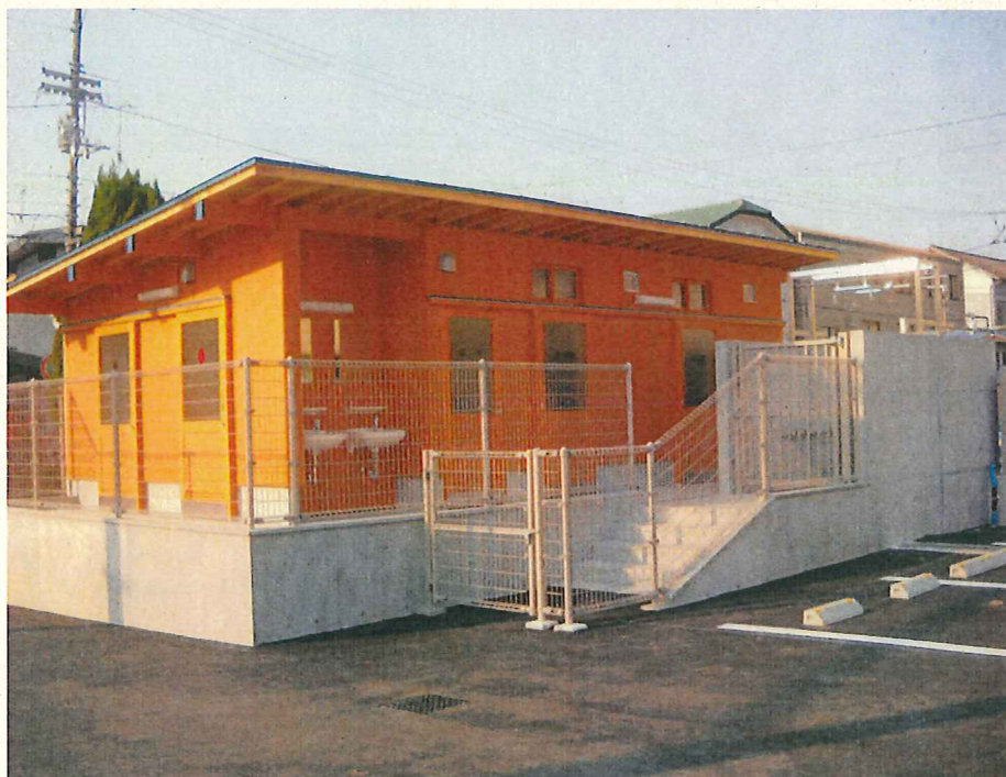
完了(プール附属棟)
