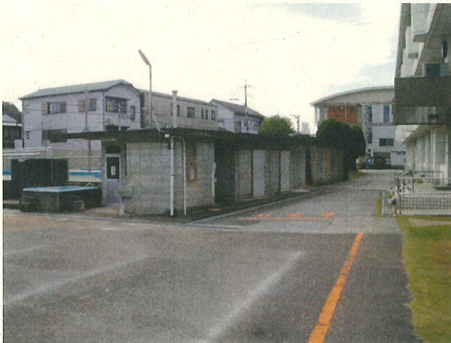
着手前(プール附属棟)
