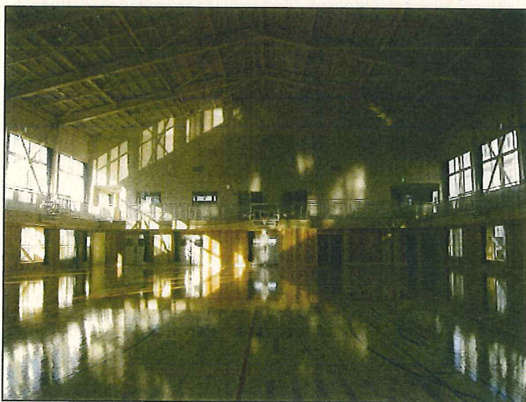
高岡高校体育館改築主体工事
