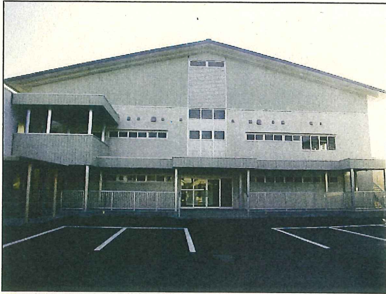
高岡高校体育館改築主体工事
