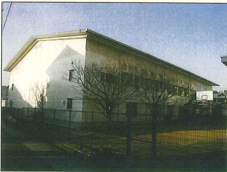
高岡高校体育館改築主体工事
