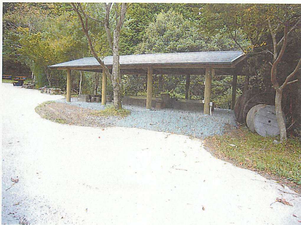
完成写真 炊事棟東南面
