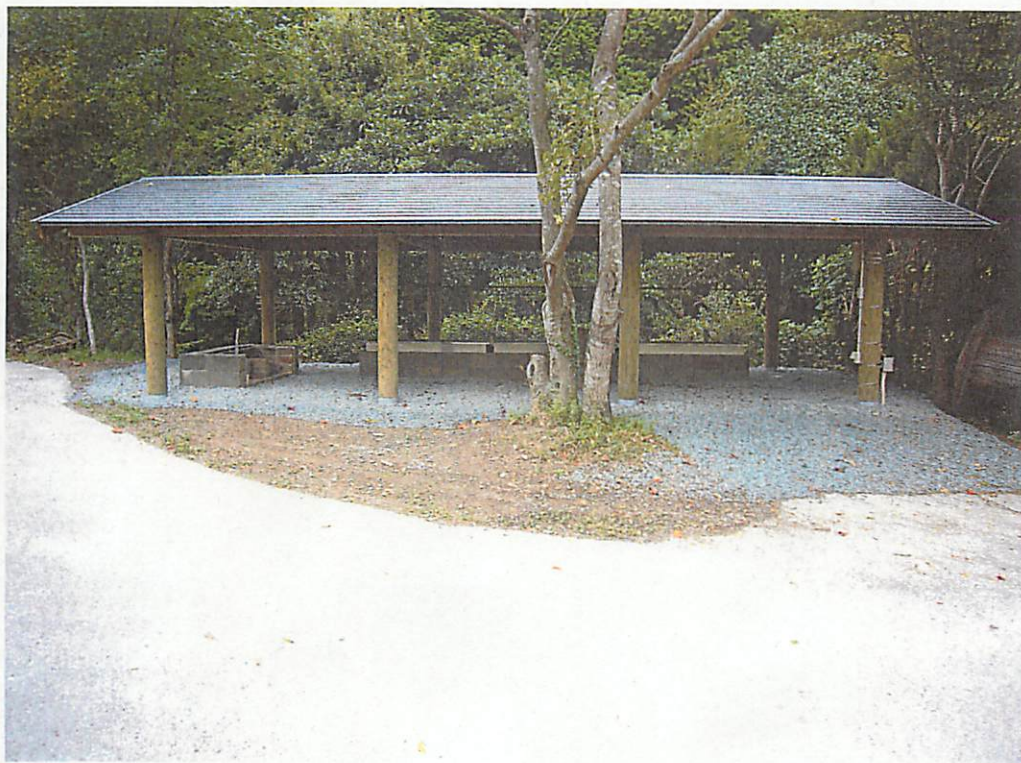
完成写真 炊事棟南面
