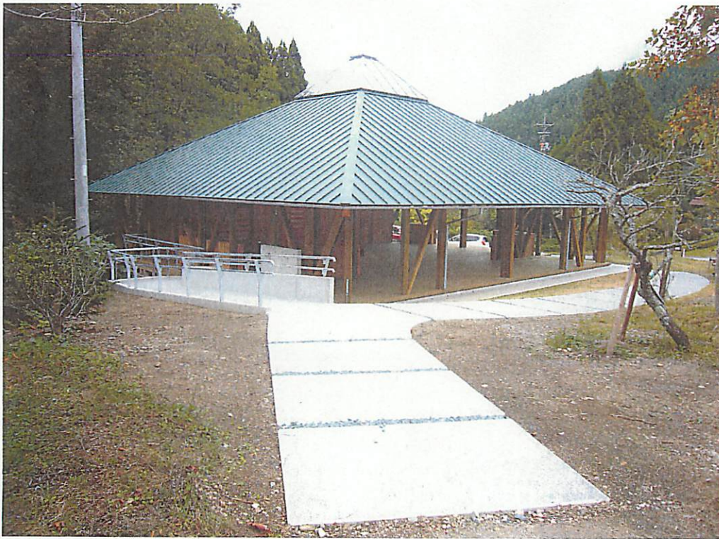
完成写真 研修棟西面
