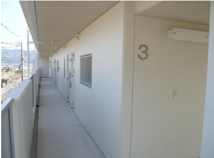
あき総合病院医師公舎Ⅳ建築主体工事
