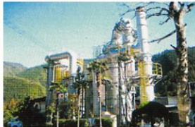
[廃棄物の焼却施設（縮減）]
